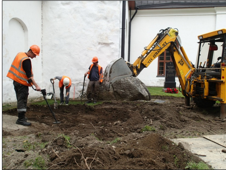
Pintamaakerrosta kaivetaan pois.
